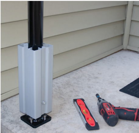
Properly anchor post mount.
